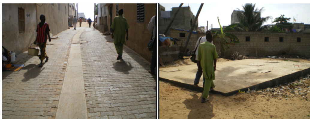
FIGURE 11 – Rue pavée et réacteur à chicanes (RAC) construit par le projet Live-with-Water à Bene Baraque, le 11 novembre 2015
