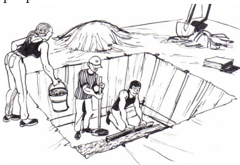
Coulage du radier de béton de 10 cm
