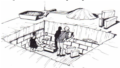
Maçonnerie en briques pleines
