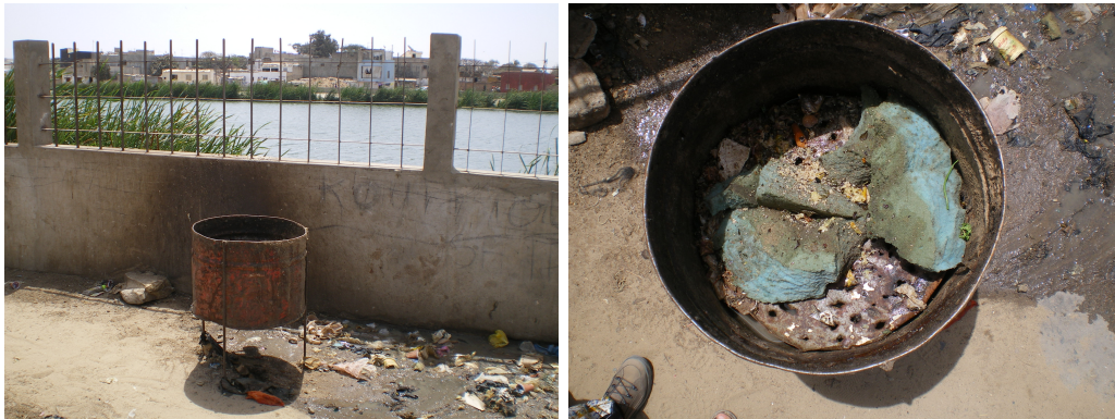
FIGURE 13 – Tamis au bord du bassin de Nietty Mbar (DTK). Le jour de la visite (14.04.2016), le tamis était inutilisé (tuyau déconnecté) et les eaux usées jetées directement dans le bassin, à travers le grillage.
