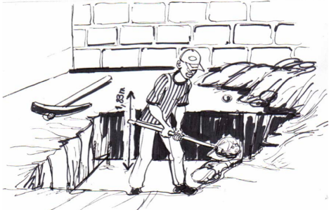
Damage du sol et coulage du béton de propreté
