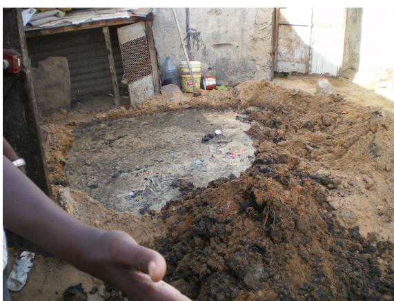
FIGURE 19 – Vidange manuelle à l'intérieur de la concession. DTK, 11.11.2015
